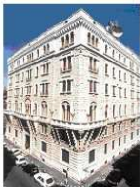
Fig. 1 - Il "Palazzo dell'Acqua"
