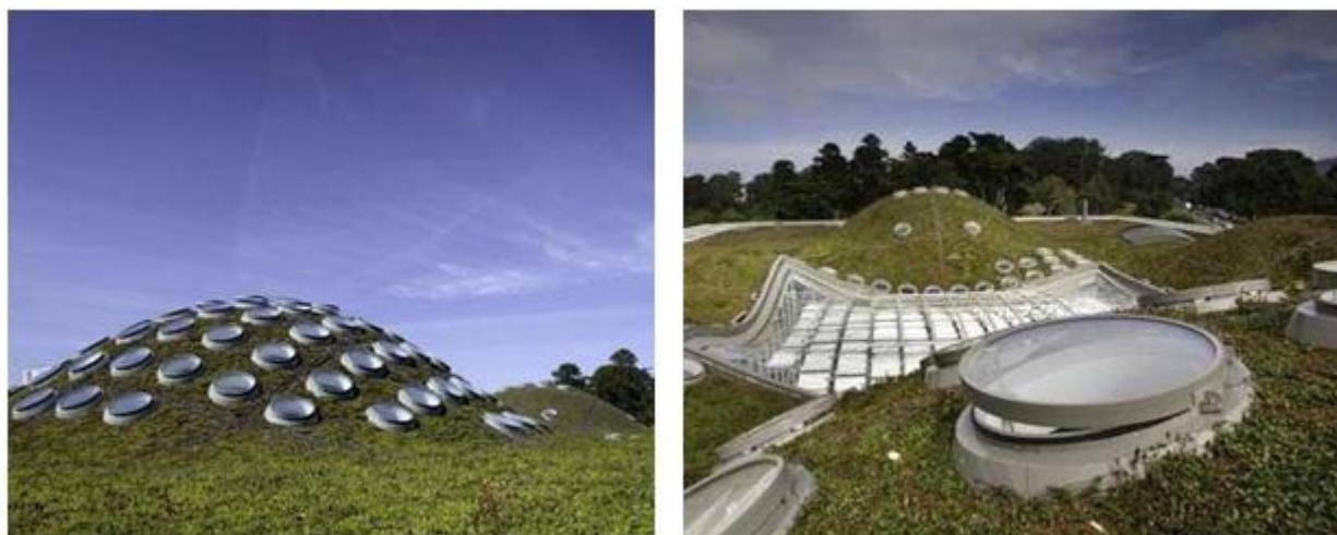
Figura 3 e 4 - Alcuni dettagli del tetto
